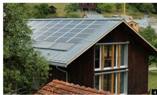
1 + 4: Die vorbildlich und sorgfältig integrierte Solaranlage auf der Ostseite (1) des Dienstleistungsgebäudes und die Anlage auf der Westseite (4) generieren insgesamt 31'557 kWh/a. Die 5 m 2 solarthermische Anlage auf der Westseite versorgt das Gebäude zusätzlich mit Warmwasser (4). 2: Ökologisch sanieren heisst nicht auf Arbeitskomfort verzichten. Auch die Innenräume wurden nach dem neusten Stand der Technik saniert. 3: Die rustikale Holzfassade des ehemaligen Stalles blieb auch nach der Sanierung erhalten. 5: Der Innovative Haustechnikplaner Hans Luzi Züst hat mit der 207%-Eigenenergieversorgung seines PlusEnergiebaus den Schweizer Solarpreis 2009 verdient.
